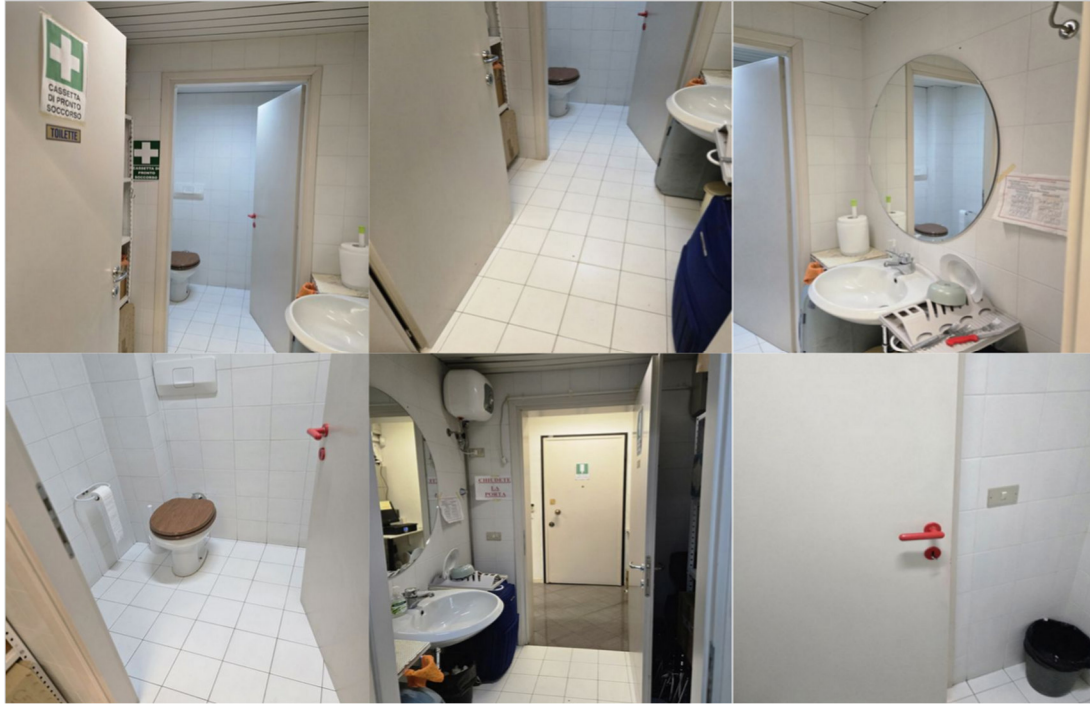
Fig.9-Anti-Bagno, WC; vedasi pianta. Finito con rivestimento a tutta altezza delle pareti in piastrelle quadrate dim.20x20, come il pavimento. Completo di sanitari e rubinetteria: water e lavello. Lavello con piano in pvc. Il bagno è dotato di un boiler per l'acqua calda sanitaria.
