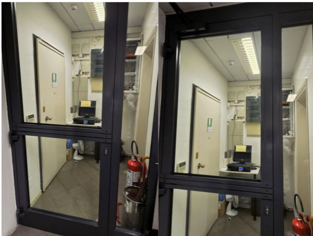
Fig.7-Seconda porta in ferro con vetro antisfondamento di accesso all'ufficio.
