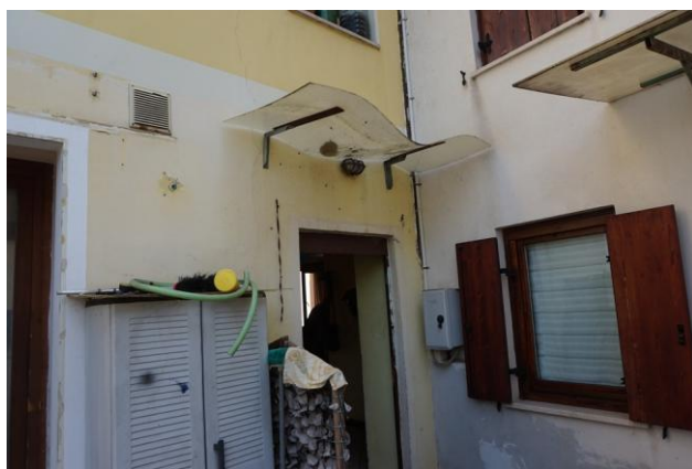
Particolare ingresso da corte comune ad est
