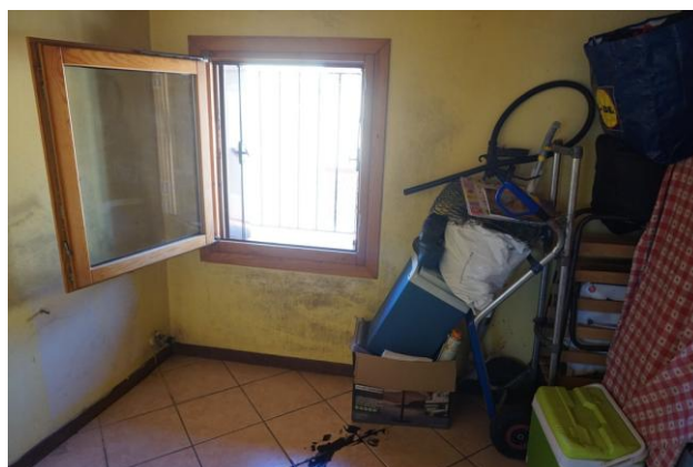
Piano secondo – Soffitta a sud
