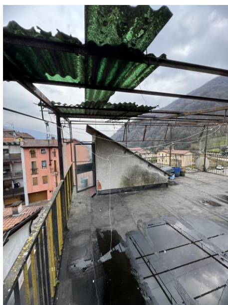
Foto n. 11 – Scala esterna terrazzo
