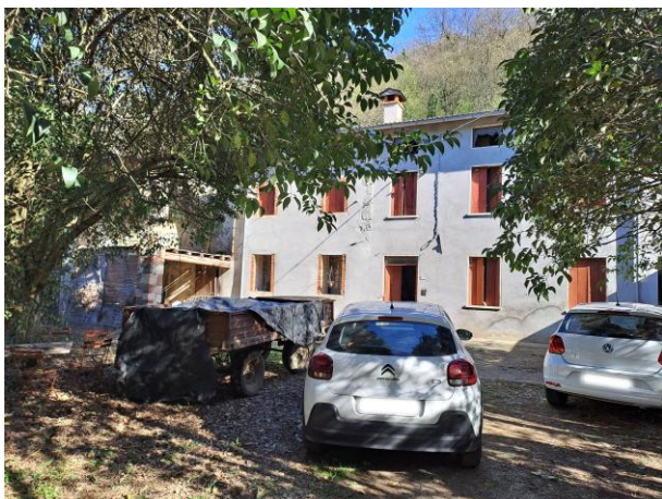
Vista generale da Sud
