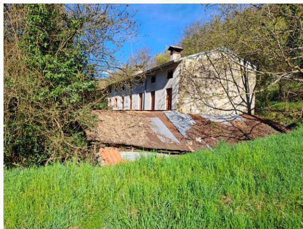
Vista generale da Est
