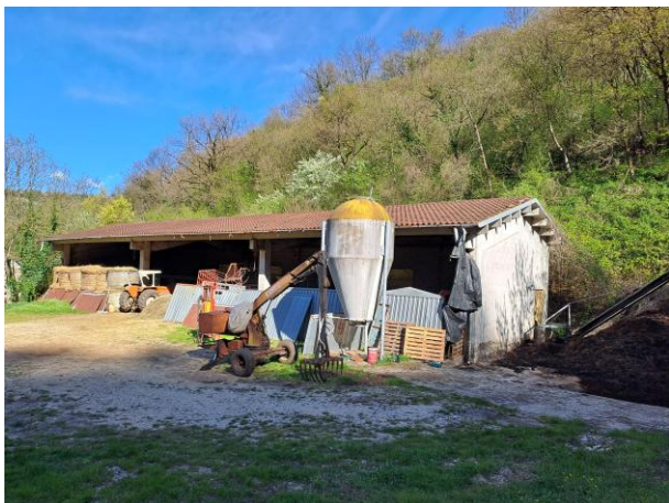
Vista generale da sud - est
