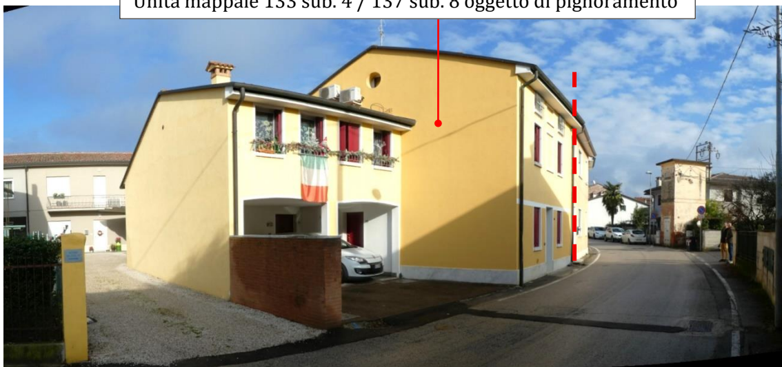
2. – Fabbricato mappale 133-137 – lato Sud/Ovest fronte Via IV Novembre
