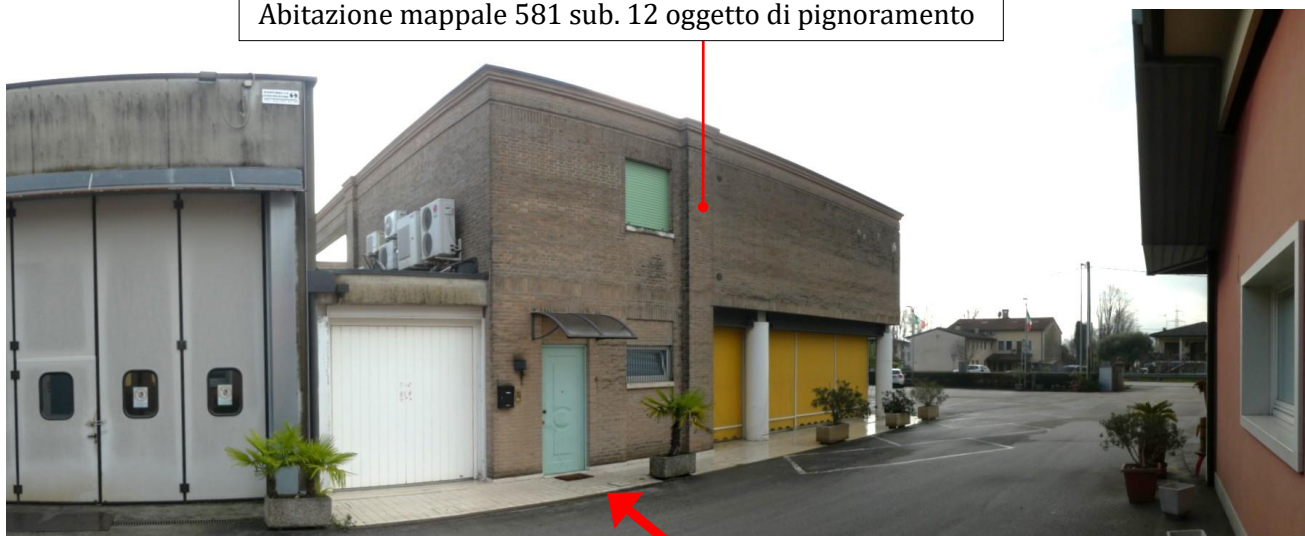
5. – Fabbricato mappale 581 – lato Nord con accesso all'abitazione sub. 12 dal piano Terra
