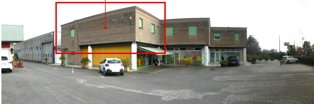
3. – Fabbricato mappale 581 – lato Nord/Ovest fronte corte comune
