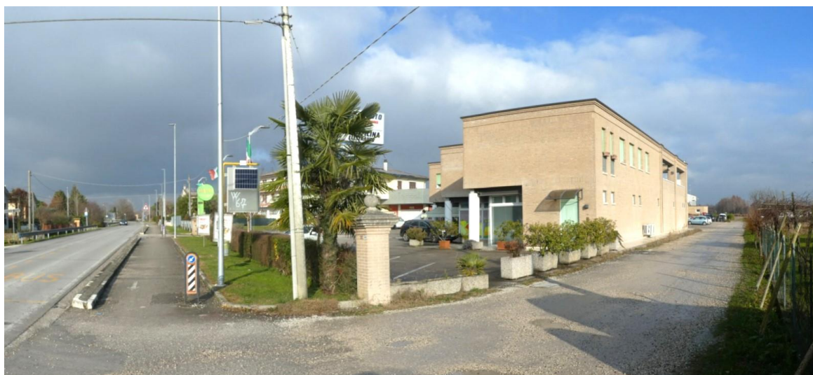
2. – Fabbricato mappale 581– lato Sud/Ovest fronte Via palazzina
