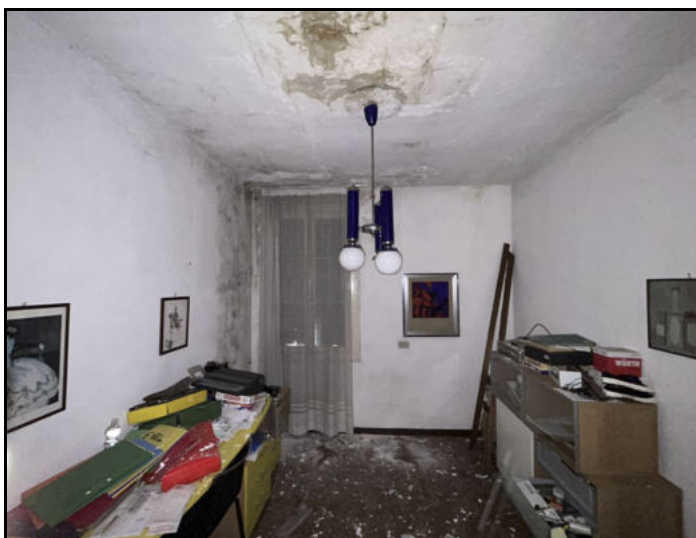
Camera centrale lato nord ovest
