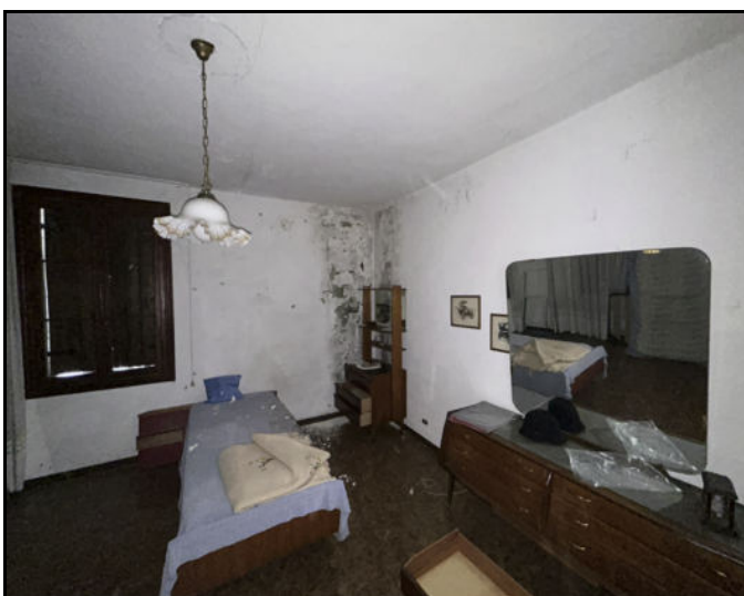
Camera lato sud ovest
