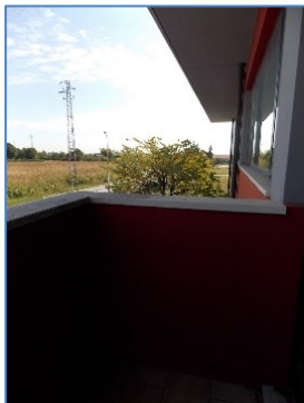
terrazza e accesso vano caldaia
