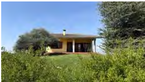
Vista esterna edificio
