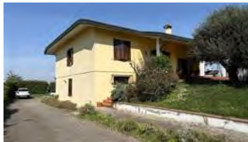
Vista esterna edificio
