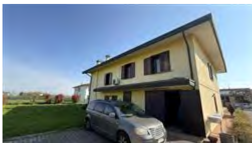
Vista esterna edificio
