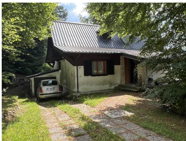
Vista dell'edificio da Nord Est
