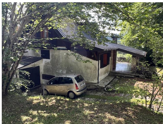
Vista dell'edificio da Nord Ovest
