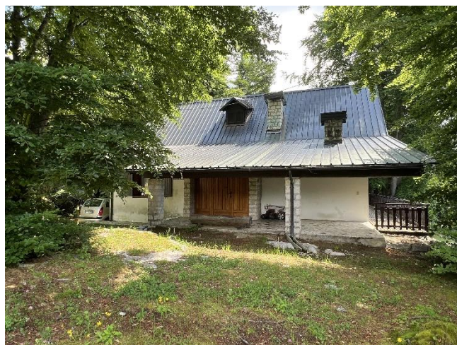
Vista dell'edificio da Sud Ovest
