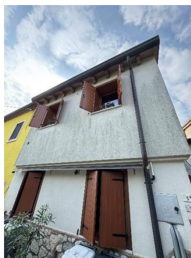
Foto n. 15 – Immobile prospetto Nord
