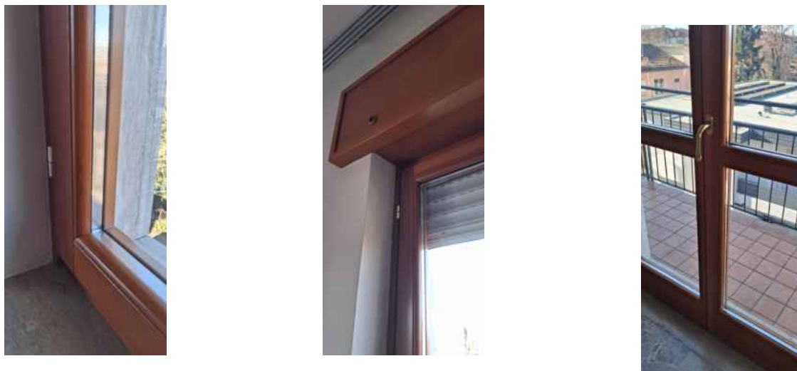
Figura 25. dettagli finiture serramenti esterni
