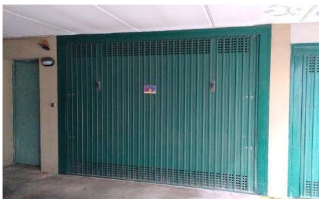
Esterno garage e porta centrale termica
