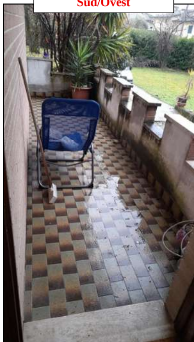
Balcone angolo Sud/Ovest
