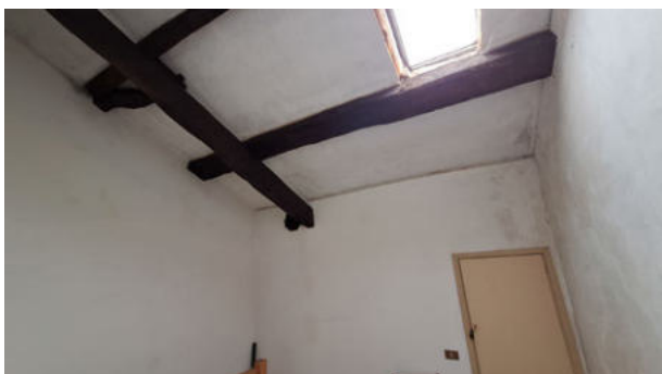
VISTA SOFFITTA P. 2°
