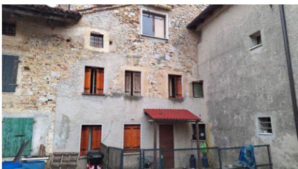
VISTA ESTERNA FIANCO OVEST
