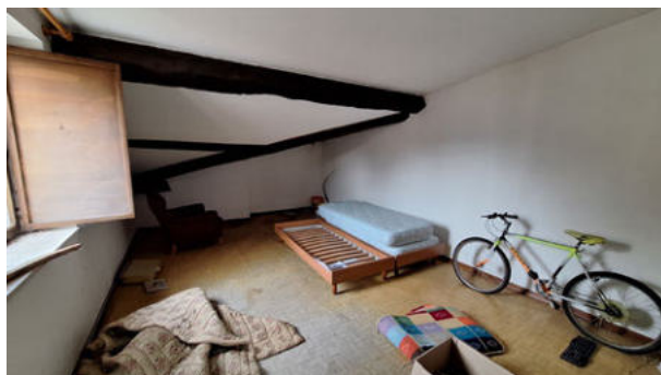
VISTA SOFFITTA P. 2°
