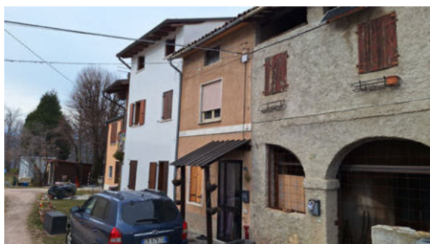
VISTA ESTERNA FRONTE SUD
