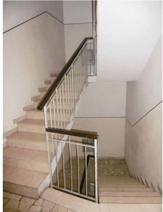
vano scale comune
