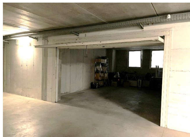
Vista dell'autorimessa al piano 2 interrato
