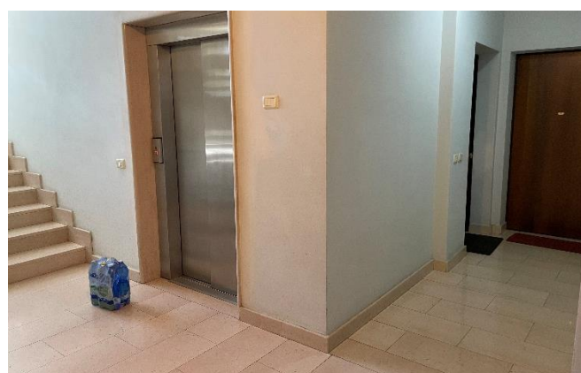
Vista del vano scala condominiale di accesso all'abitazione
