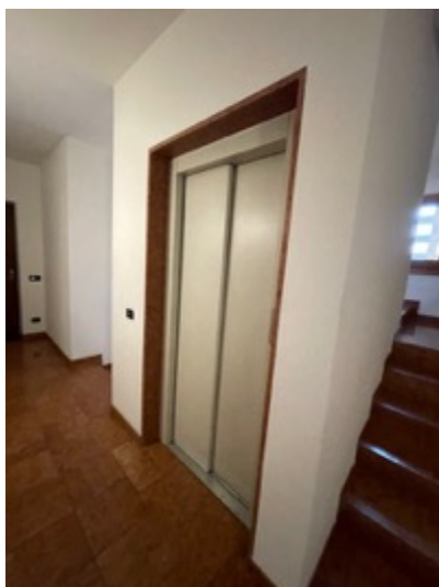
Figura 10. Foto immobile – Vano scala comune - Ascensore
