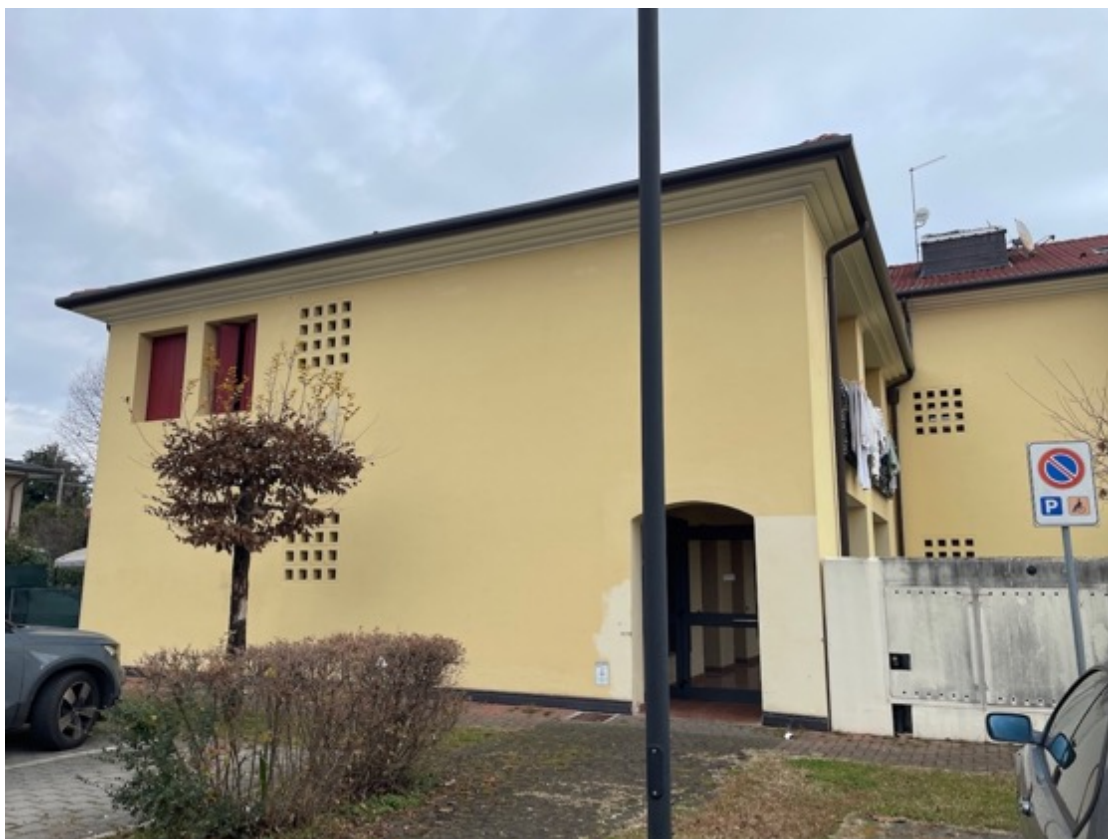
Figura 5. Foto immobile – Esterno lato Ovest – vista dalla strada
