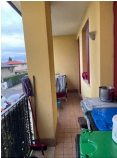
Figura 14. Foto immobile – Loggia lato Sud
