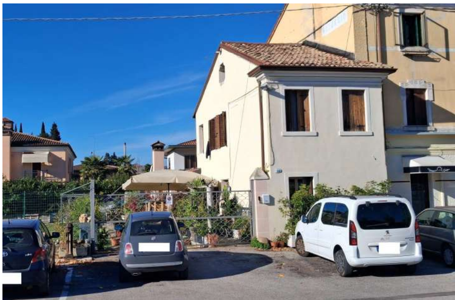
Figura 10 - accesso pedonale e carraio da via Prato Santa Caterina n.10
