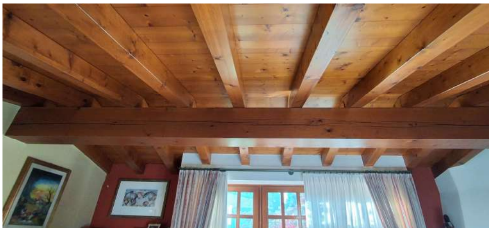
Figura 20 - P.la 953 sub.1 locale soggiorno dettaglio copertura in legno
