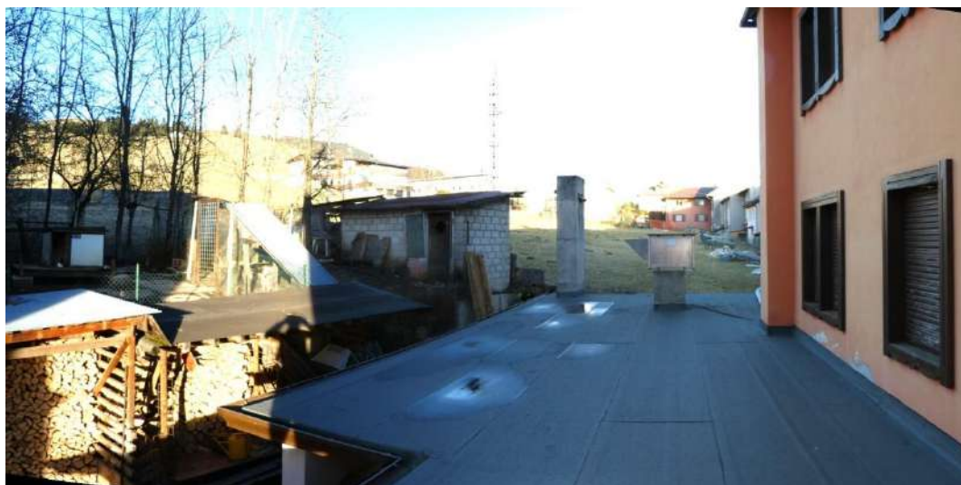
36. –Terrazza esterna – lato Nord piano Primo
