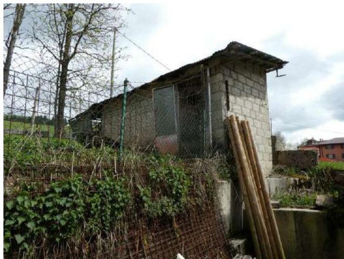
8. – Manufatto ad uso Ripostiglio/Deposito sul mapp. 1430 – lato Sud/Ovest
