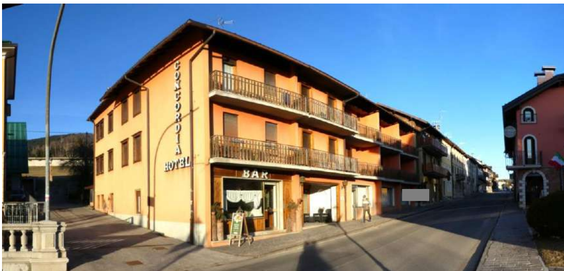
1. – Alberg / Ristorante Concordia – lato Sud/Ovest fronte Via Roma
