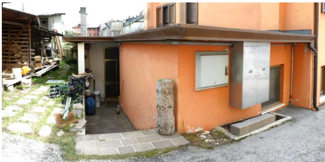
11. – Accesso all'Interrato ad alla cucina dal lato Nord/Ovest
