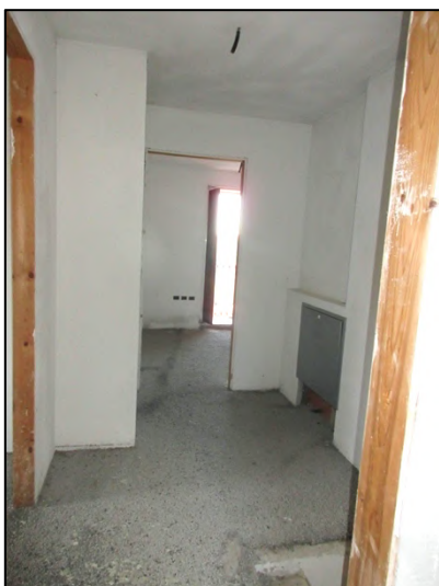
PIANO PRIMO disimpegno
