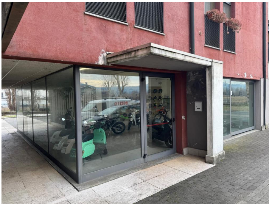
5. – vista panoramica lato Sud-Est
