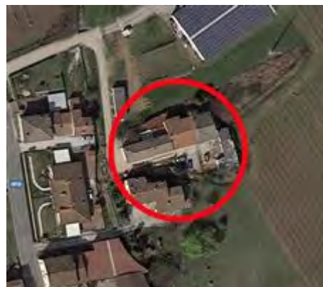
Foto Aerea Particolare
