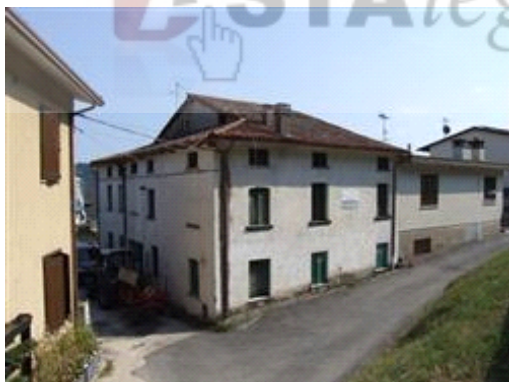
Veduta dell'immobile da Nord-Ovest
