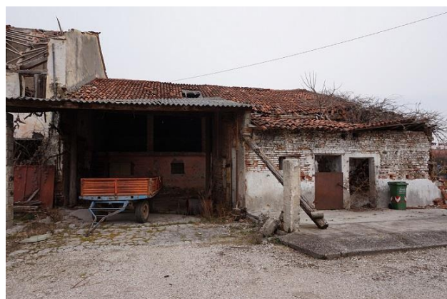
Fronte sud da corte comune (particolare)
