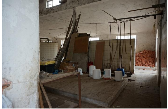
Interno ex sala mungitura da sud/ovest
