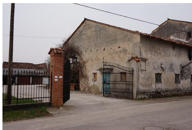
Ingresso da Via Chiesa Sud
