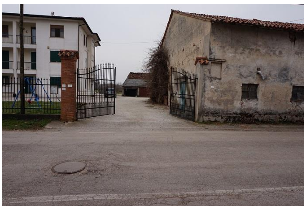
Ingresso da Via Chiesa Sud
