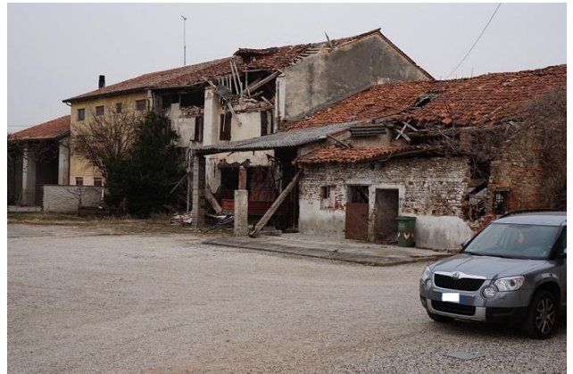
Vista da corte comune (da sud/est)
