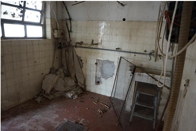
Interno angolo sud/est ex sala mungitura
