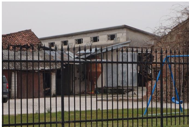
Fronti est e nord edifici az. agricola da Via Chiesa sud
