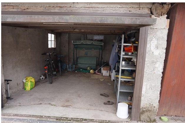
Rimessa da nord verso sud
