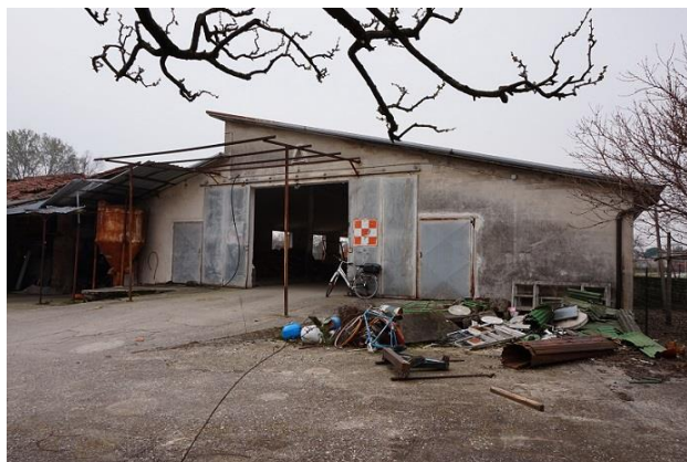
Edifici azienda agricola da corte comune (da nord/ovest)
