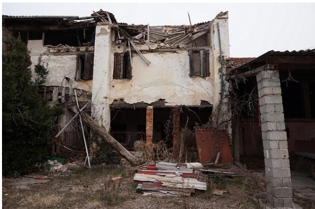
Fronte sud da corte interna
