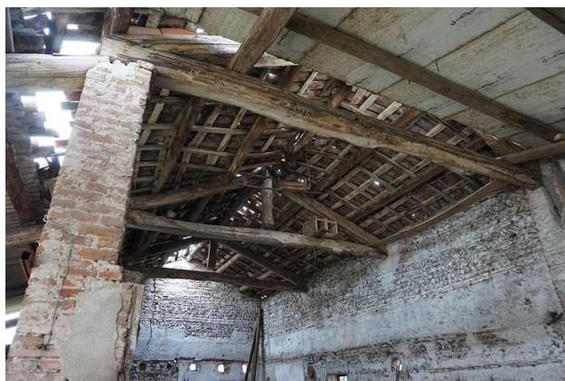
Ripostiglio attrezzi e macchine (particolare copertura)
