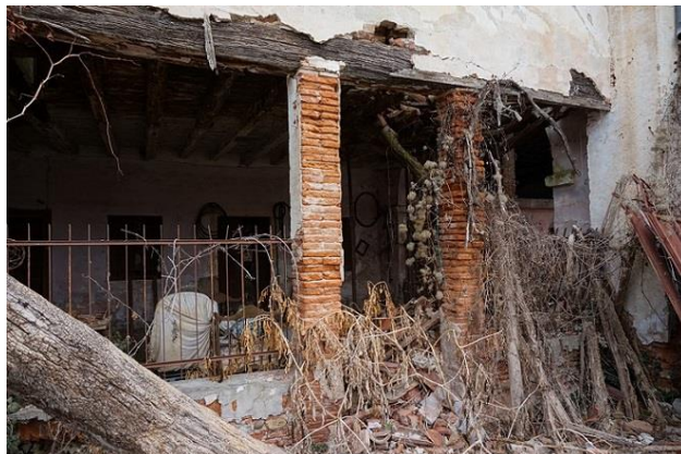
Fronte sud da corte interna (particolare)
