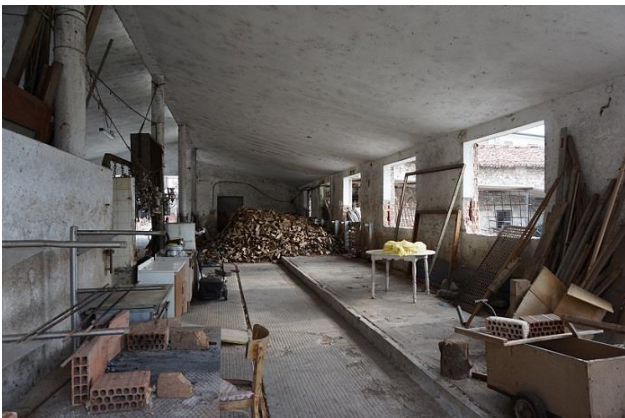
Interno angolo nord/est
