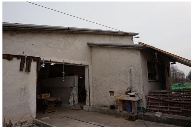
Area esterna a sud (da est verso est)
