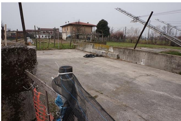
Angolo sud/ovest area esterna
