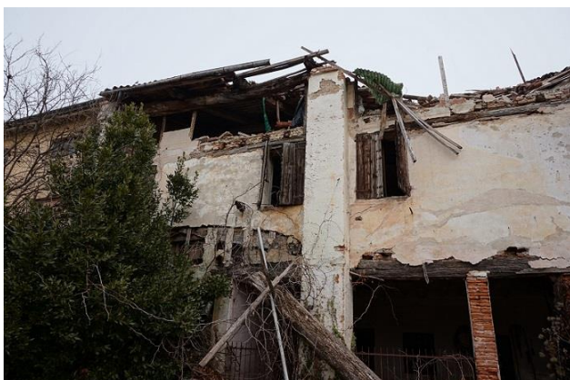
Fronte sud da corte interna (particolare)
