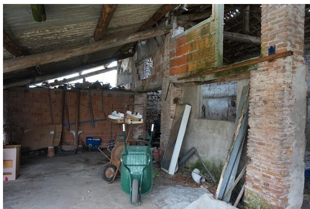
Ripostiglio attrezzi e macchine da ovest verso est
