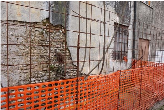
Recinzione di cantiere (particolare)
