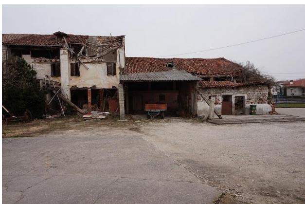
Fronte sud da corte comune
