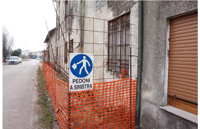
Recinzione di cantiere su fronte nord (da ovest verso est)
