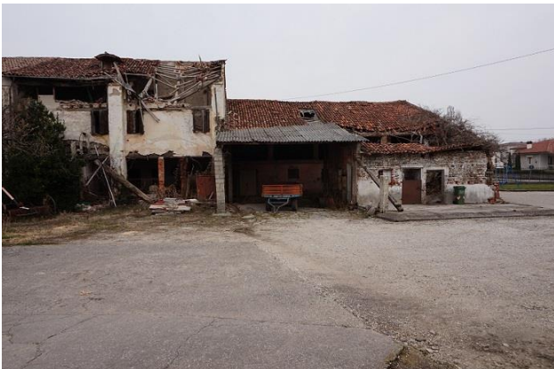
Fronte sud da corte interna
