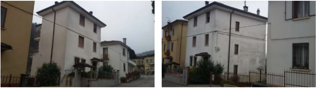
Figura 3. Foto esterne immobile.
