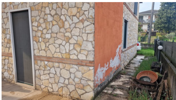
ESTERNO LATO EST
