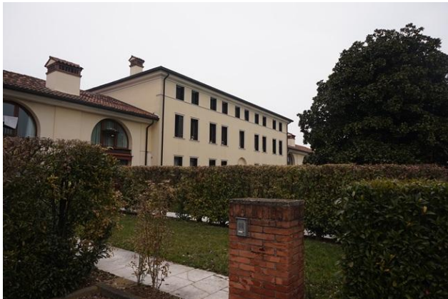
Vista fronti sud e ovest fabbricato principale
