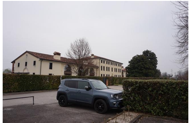
Vista fronti sud e ovest fabbricato principale
