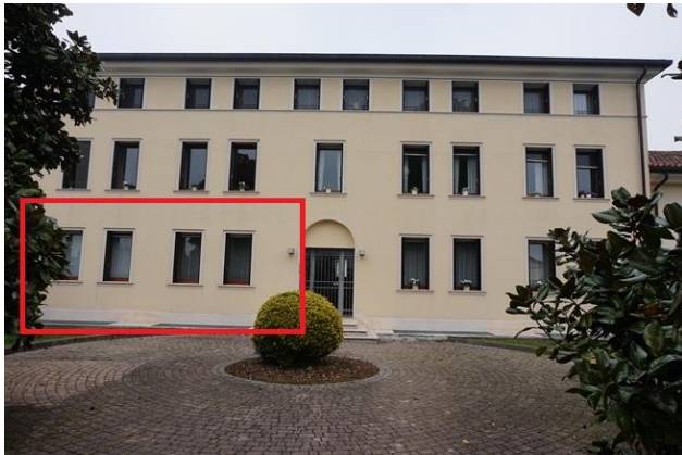
Vista fronte sud fabbricato principale
