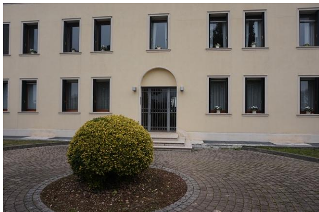
Particolare ingresso comune a sud
