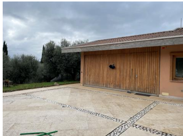
accesso autorimessa da altra proprietà
