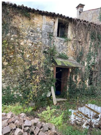
vista fabbricato lato nord-est
