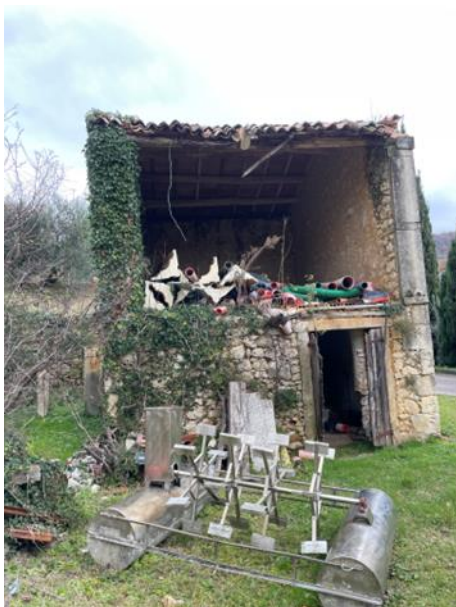
vista ovest deposito
