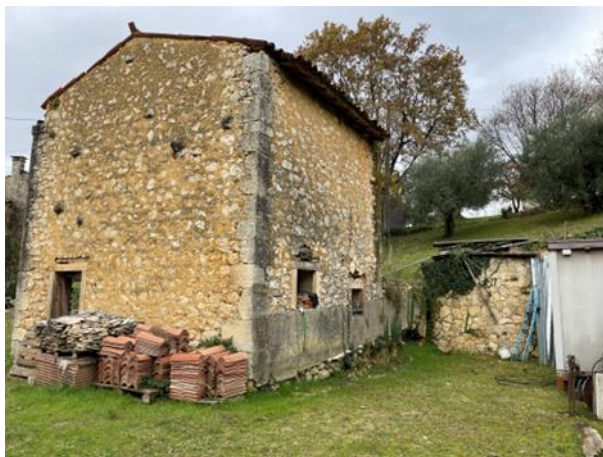
vista deposito lato nord-est
