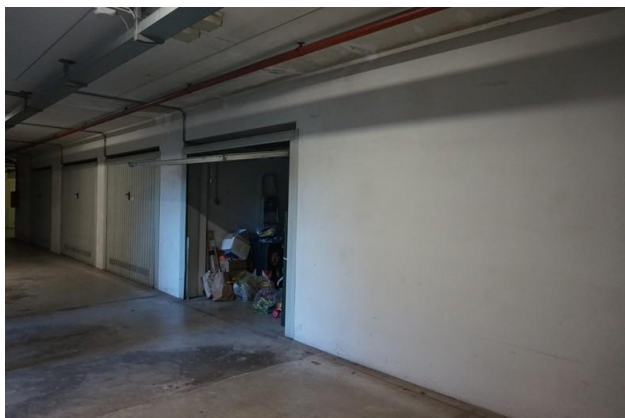
Piano interrato – Ingresso autorimessa da sud/est
