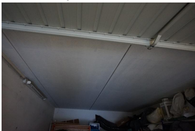
Piano interrato – Particolare soffitto autorimessa
