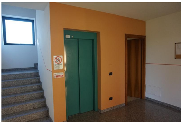
Piano terra - Zona ingresso vano scala "A"
