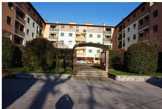
Vista ingresso pedonale a sud
