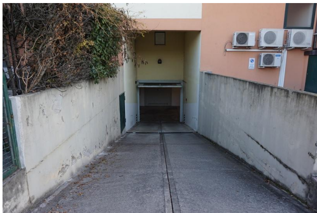
Rampa uscita a ovest
