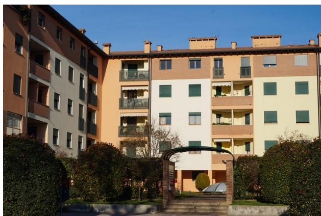
Vista ingresso pedonale a sud
