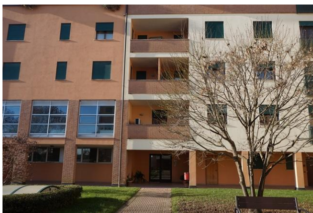
Vista ingresso vano scala "A" da cortile interno comune
