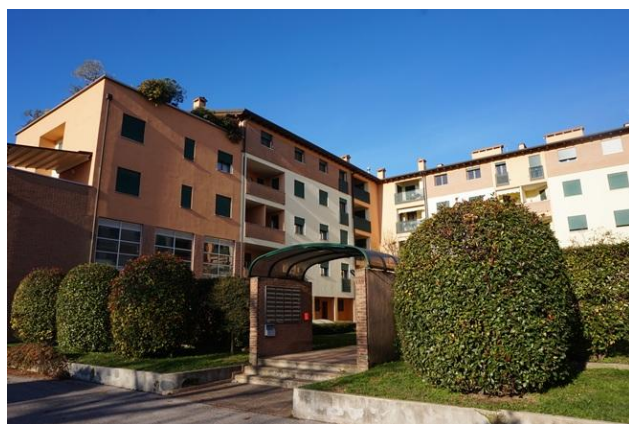
Vista ingresso pedonale da sud/est
