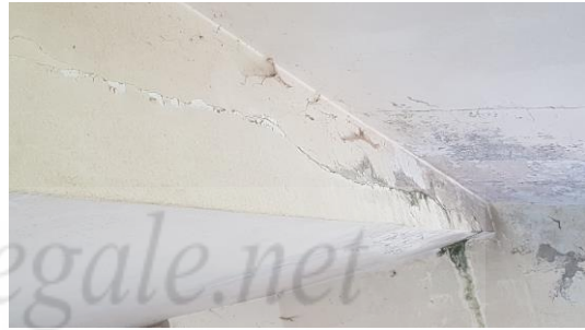
PARTICOLARE LESIONI/INFILTRAZIONI
