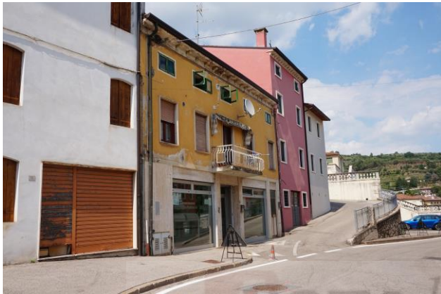
Vista da ovest fronte sud fabbricato
