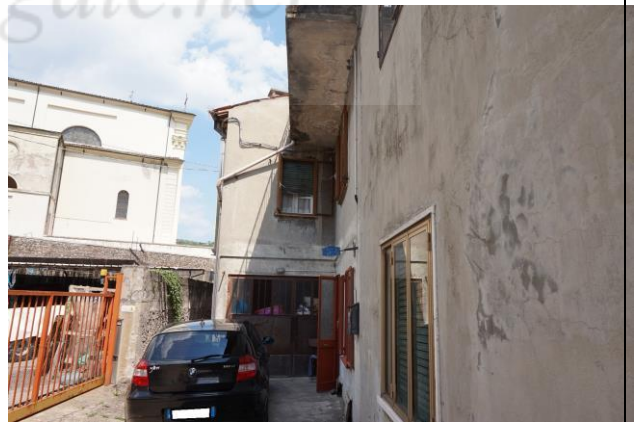
Vista fronte ovest fabbricato
