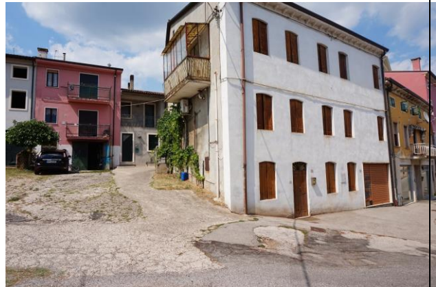
Vista accesso carraio e pedonale da sud verso nord
