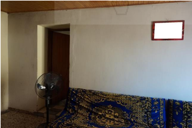
Piano primo – Soggiorno angolo nord/est
