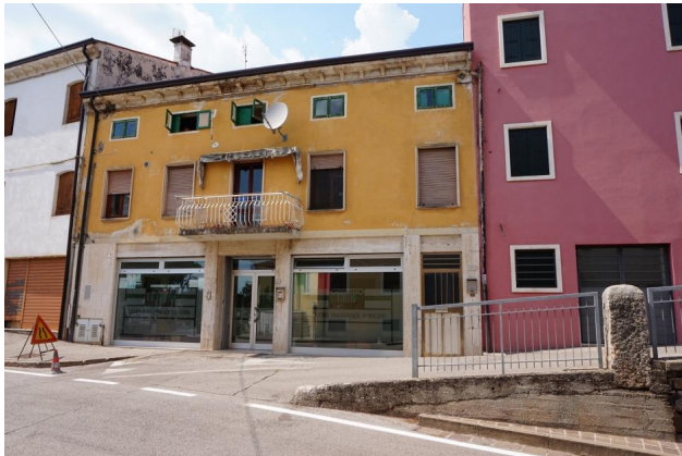
Vista fronte sud fabbricato da via Martiri della Libertà
