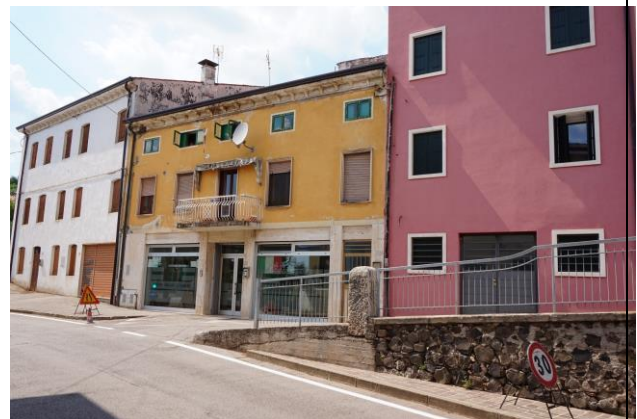
Vista sud fabbricato da via Martiri della Libertà
