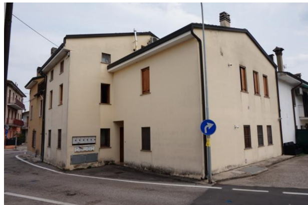
Vista fabbricato da nord/ovest
