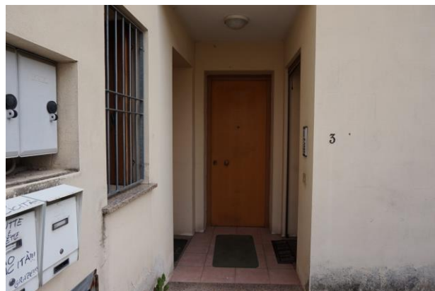
Piano Terra – Ingresso condominiale da nord
