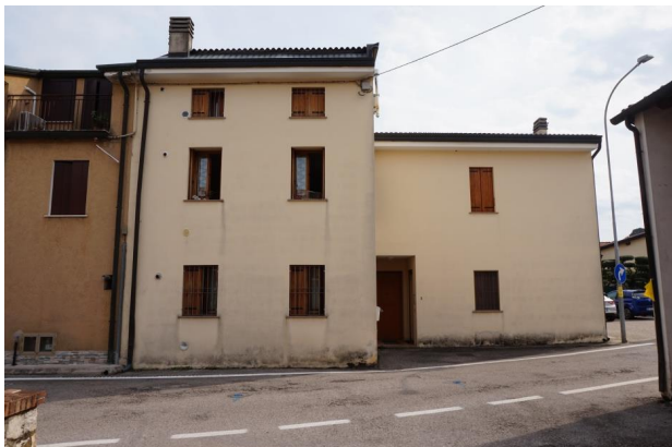
Vista fabbricato da nord
