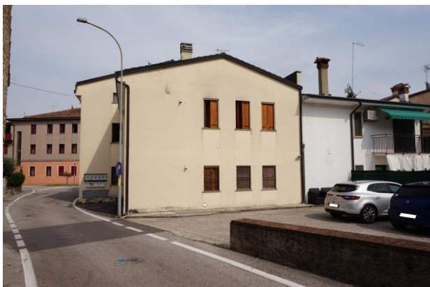
Vista fabbricato da ovest
