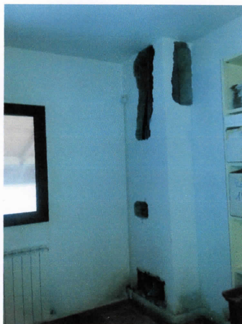
Le conseguenze di una perdita da uno scarico e della sua riparazione d'urgenza.
