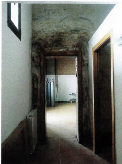
Le conseguenze di una perdita da uno scarico e della sua riparazione d'urgenza.
