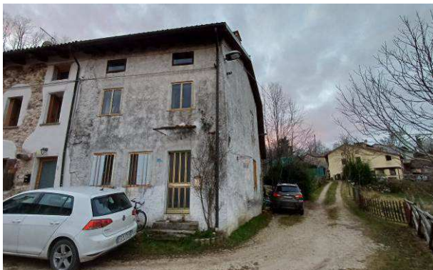
Vista esterna da nord-est
