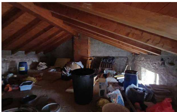
Soffitta piano secondo
