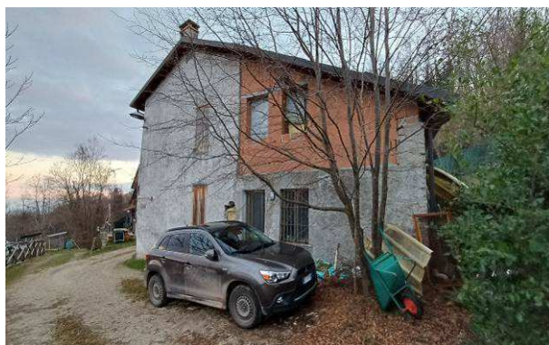
Vista esterna da nord-ovest
