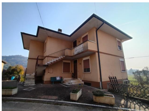
Vista esterna– prospetto nord/ovest – edificio residenziale
