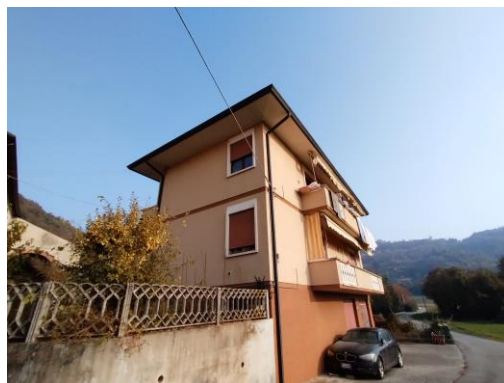
Vista esterna– prospetto sud/ovest edificio residenziale
