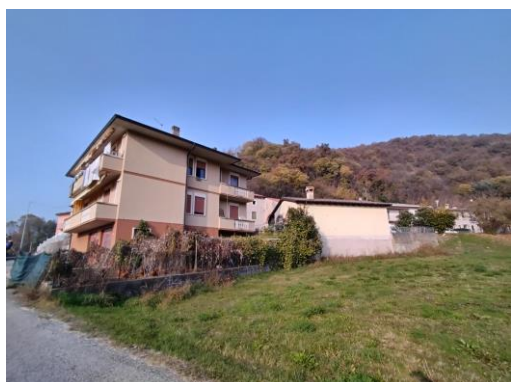
Vista esterna– prospetto sud edificio residenziale
