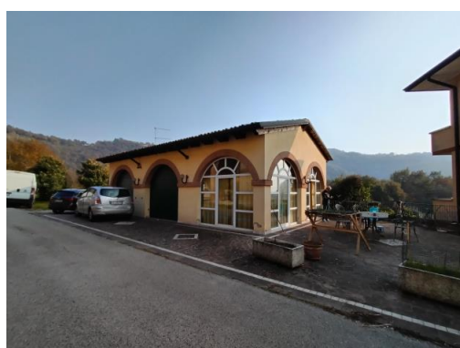
Vista esterna– prospetto nord/ovest edificio accessorio
