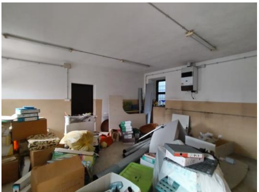
Vista interna LABORATORIO (porzione catastale foglio 31 mappale 131 subalterno 2)
