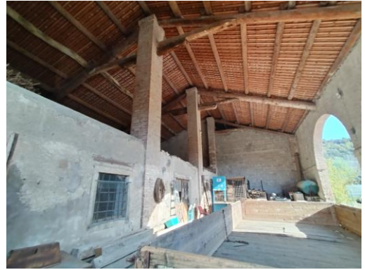
Vista interna portico
