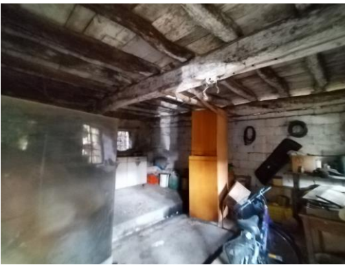
Vista interna DEPOSITO (porzione catastale foglio 31 mappale 258 subalterno 3)
