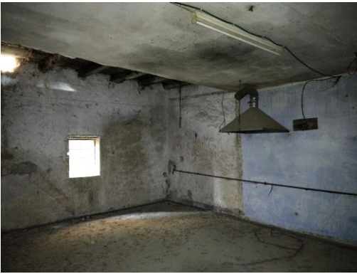
Vista interna SOFFITTA (porzione catastale foglio 31 mappale 258 subalterno 1)
