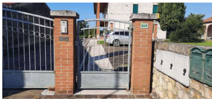
Figura 7. accesso pedonale e carroia al civico n. 8
