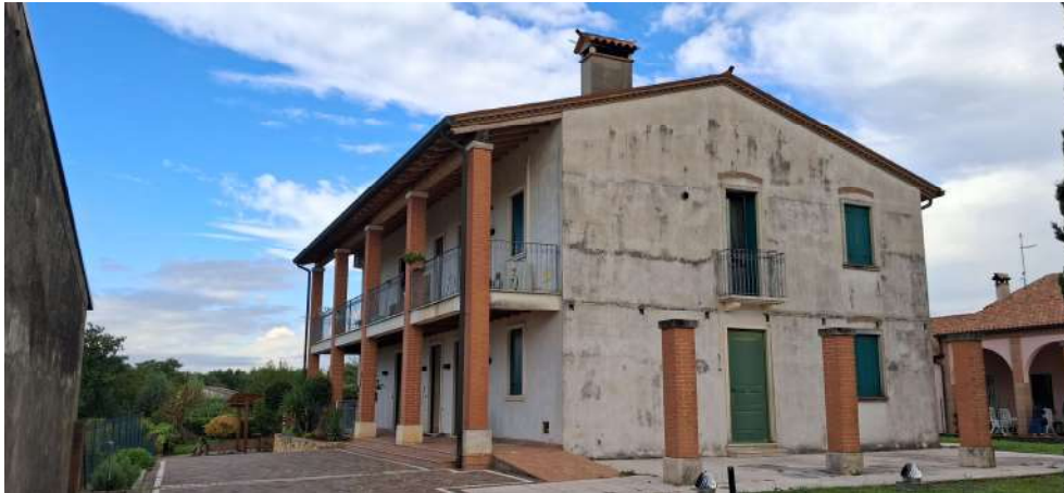
Figura 10. prospetto SUD-EST edificio plurifamiliare
