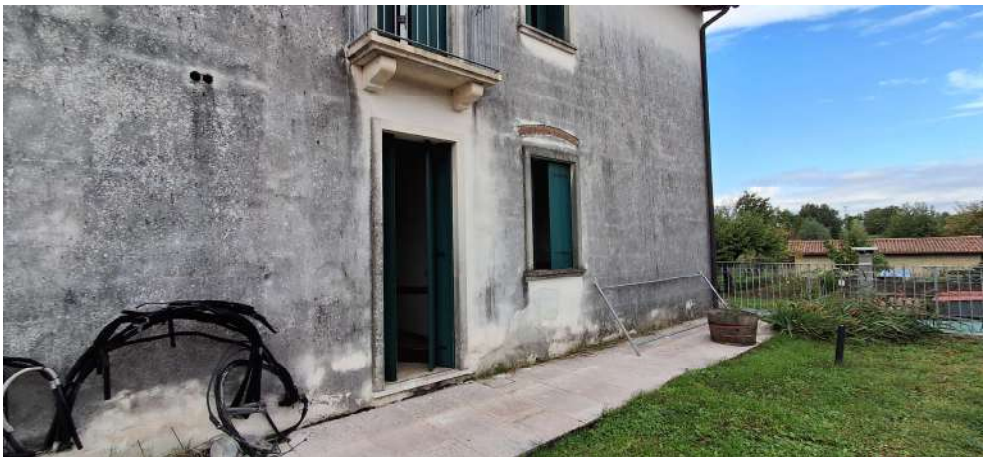
Figura 14. P.Ila 850 sub. 17 appartamento al PT prospetto NORD
