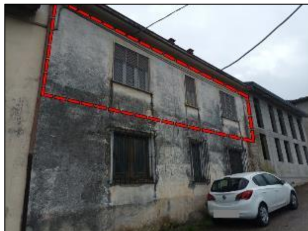
Vista dell'abitazione da Via Costa
