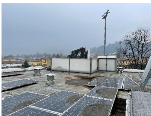
altra veduta pannelli impianto fotovoltaico
