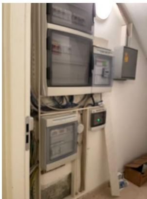
ingr. deposito s. 4
