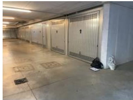
ingresso autorimessa s. 12 – area di manovra
