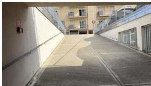
Ingresso carraio garage
