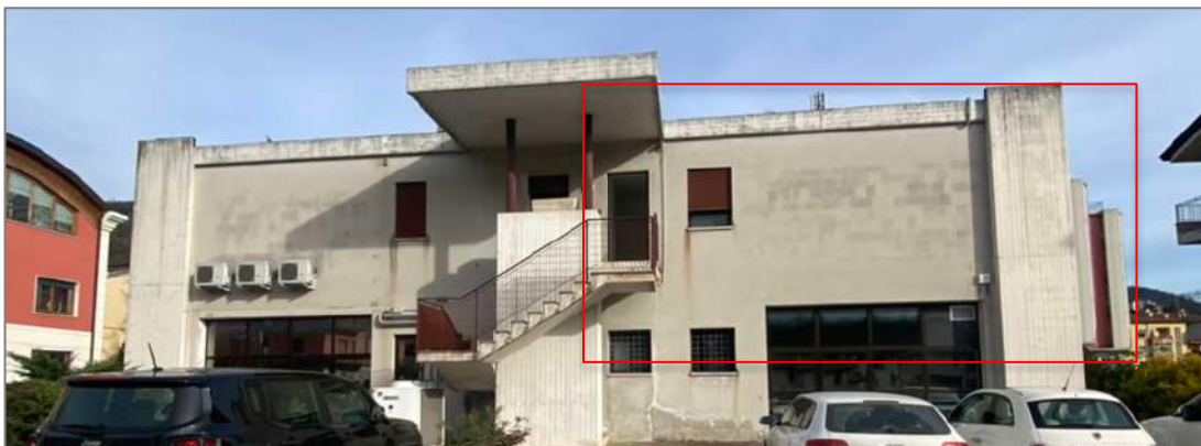
Scala di accesso al piano primo
