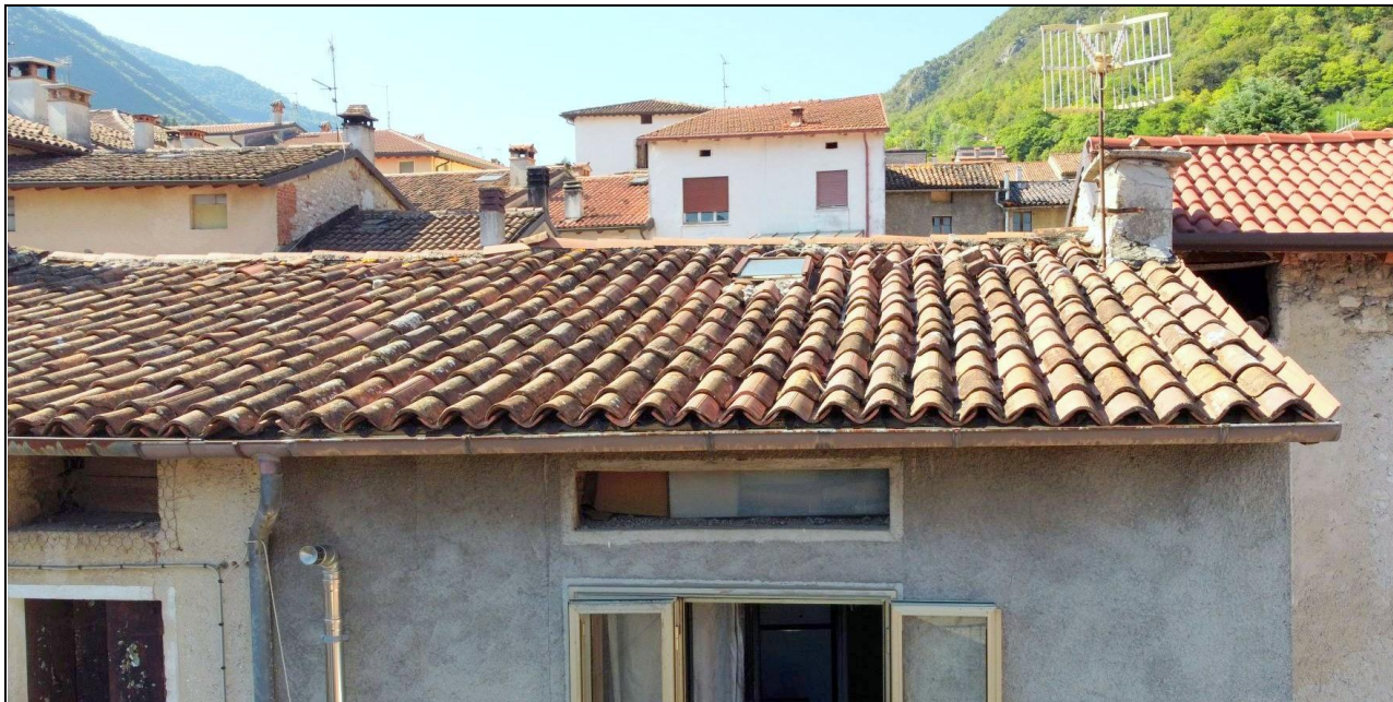
particolare piano di copertura in coppi
