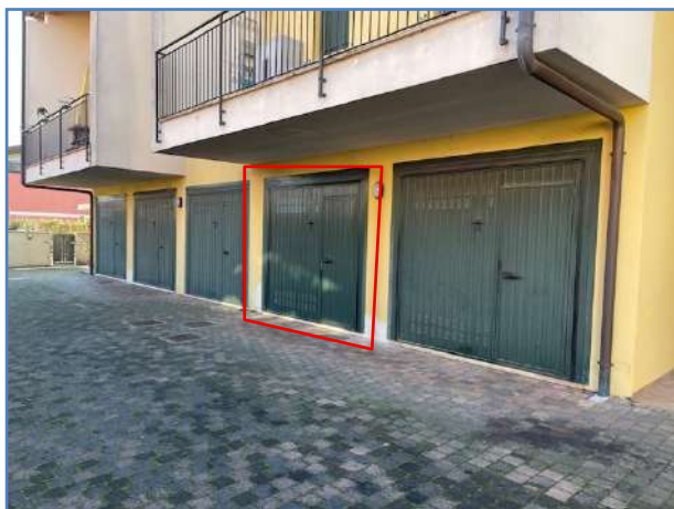
11. Prospetto Nord - Area accesso garages
