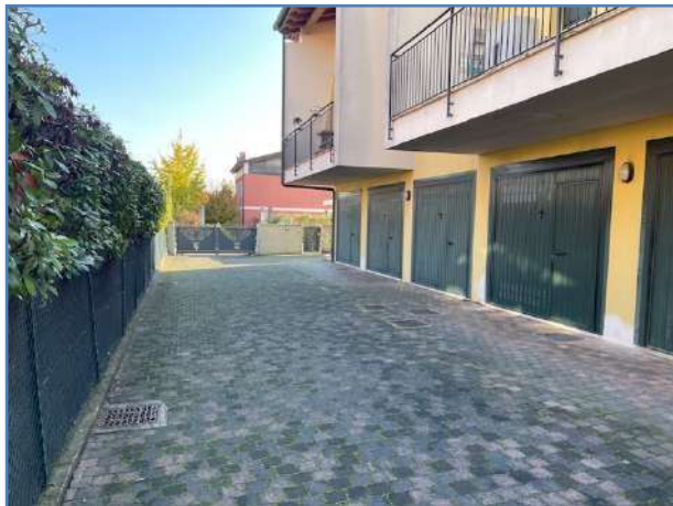
10. Prospetto Nord - Area accesso garages
