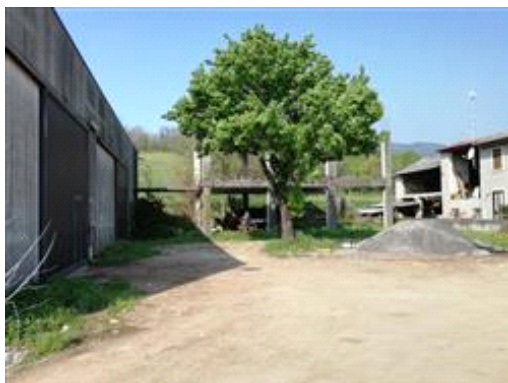
Vista esterna sul lato nord.
