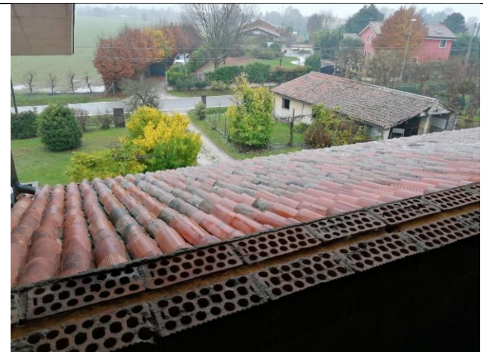
Foto 13: Vista lato ingresso
