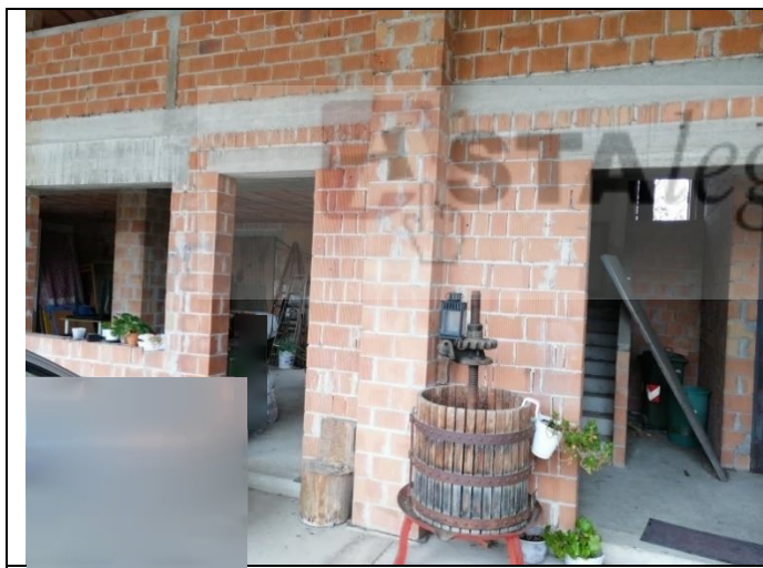
Foto 1: Ingresso portico PT
