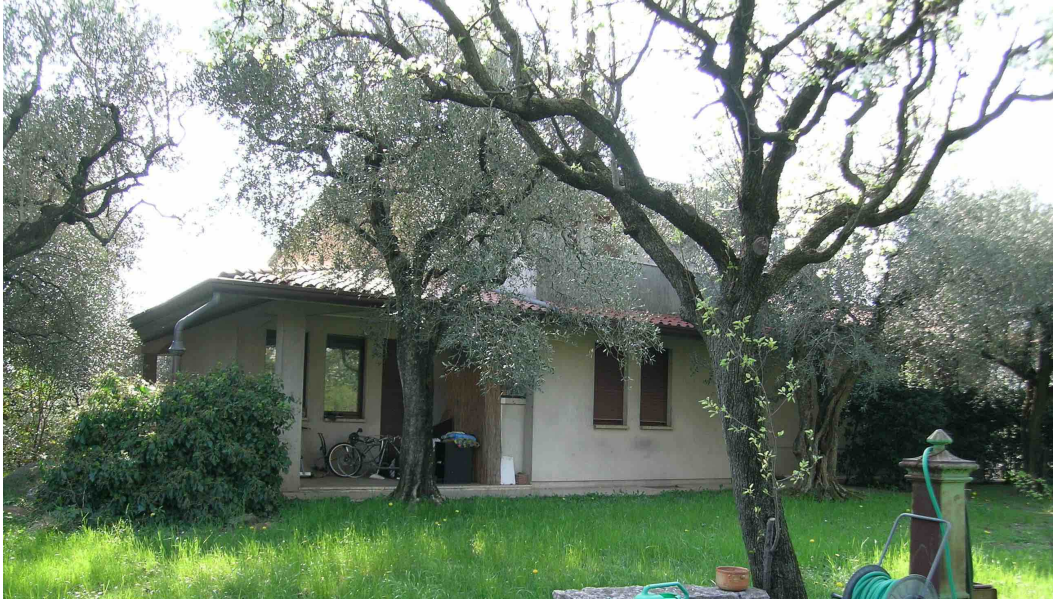
Vista del fabbricato da nord-est (immagine fotografica effettuata nel 2017)
