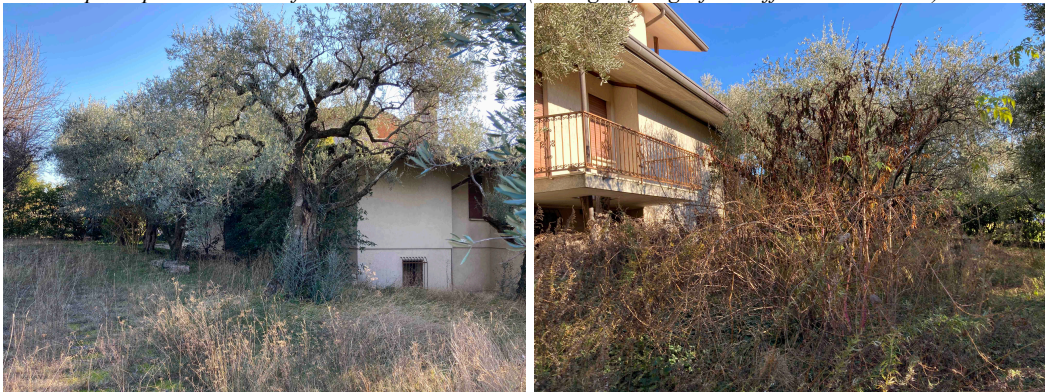
Vista esterne del fabbricato (immagine fotografiche effettuate nel 2022)
