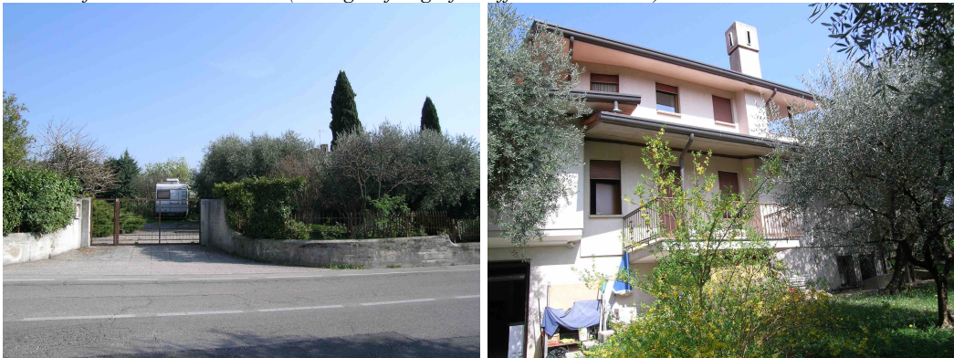
Accesso principale e vista del fabbricato da sud-ovest (immagini fotografiche effettuate nel 2017)
