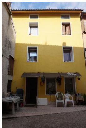
Vista fronte est porzione sud
