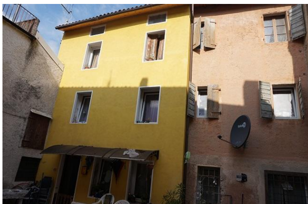
Vista fronte est porzione sud
