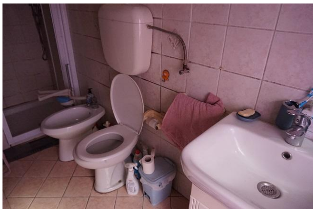
Piano Primo – Bagno a sud
