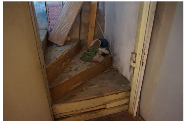
Piano Secondo – Partenza scala sud piano terzo
