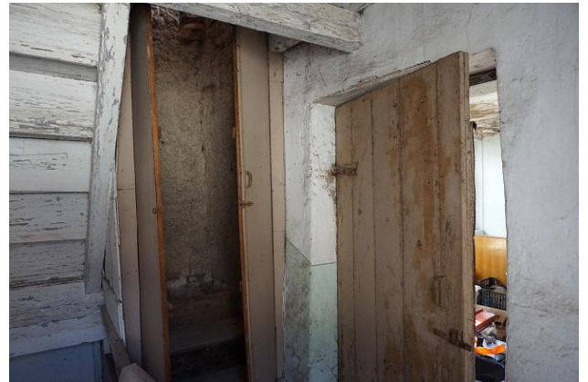
Piano Secondo – Particolare pianerottolo nord
