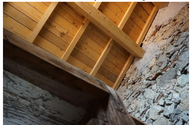
Piano Terzo – Particolare copertura soffitta nord
