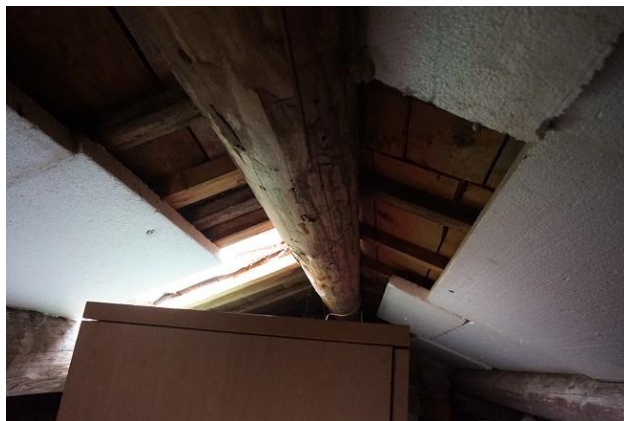
Piano Terzo – Soffitta a sud
