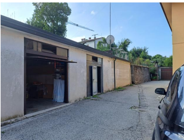
Vista dell'autorimessa da Nord-Ovest
