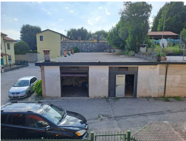
Vista dell'autorimessa da Ovest
