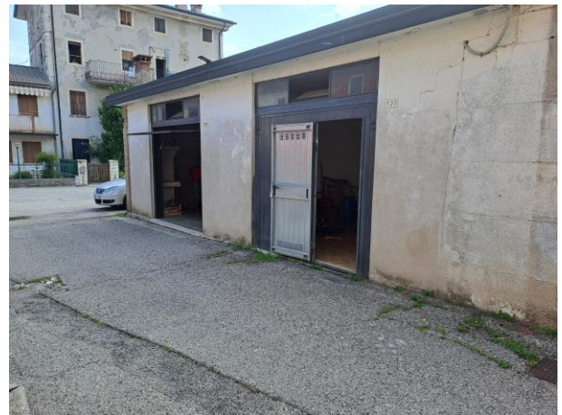
Vista dell'autorimessa da Sud-Ovest
